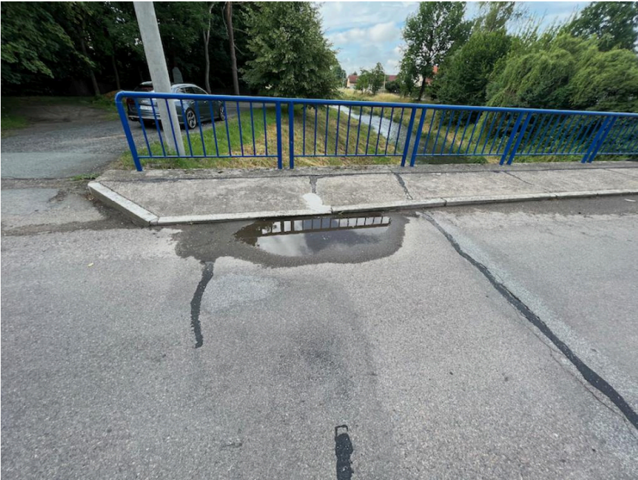
IMG_5397 - výrazný propad vozovky v okolí MZ na začátku mostu !
