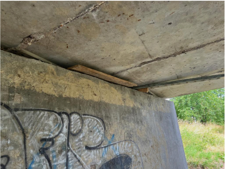
IMG_5522 – Na podhledu NK ojediněle obnažené, korodující třmínky
