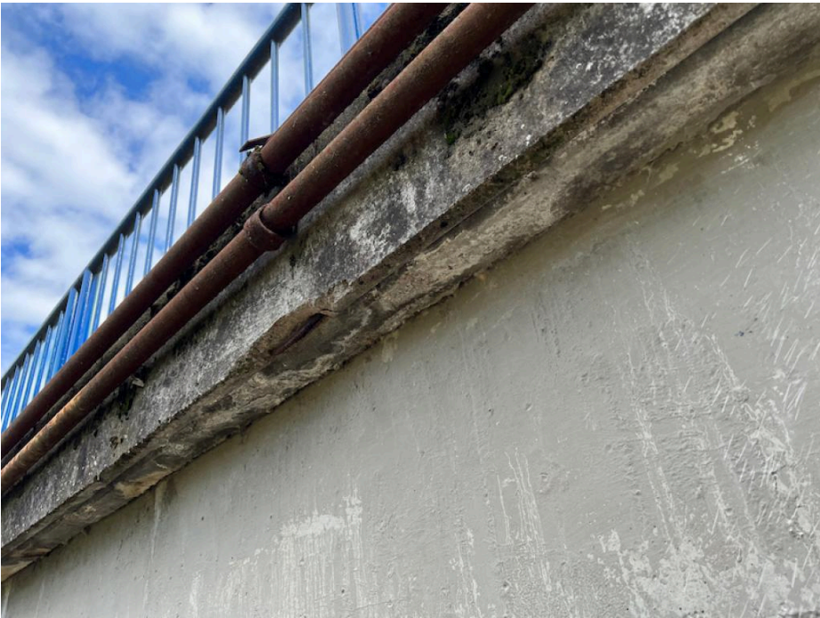
IMG_5490 - odpadlý beton a korodující výztuž na podhledu říms
