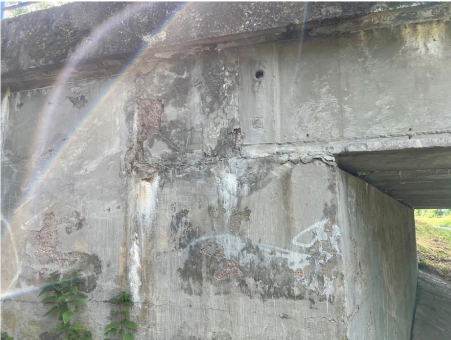
IMG_5479 - na křídlech jsou stopy po zatékání
