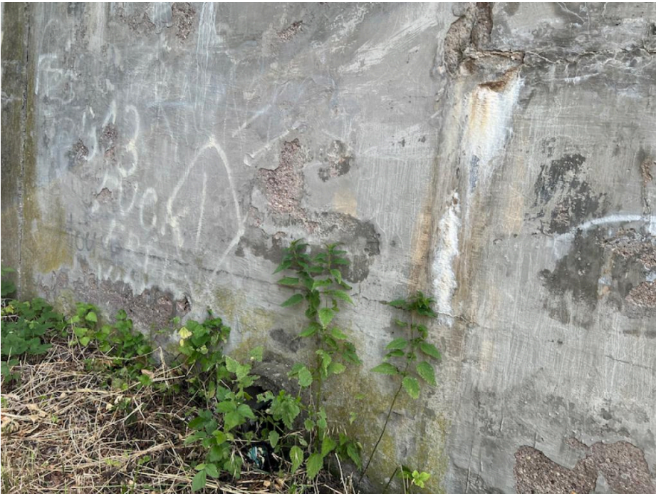
IMG_5481 - na křídlech jsou stopy po zatékání
