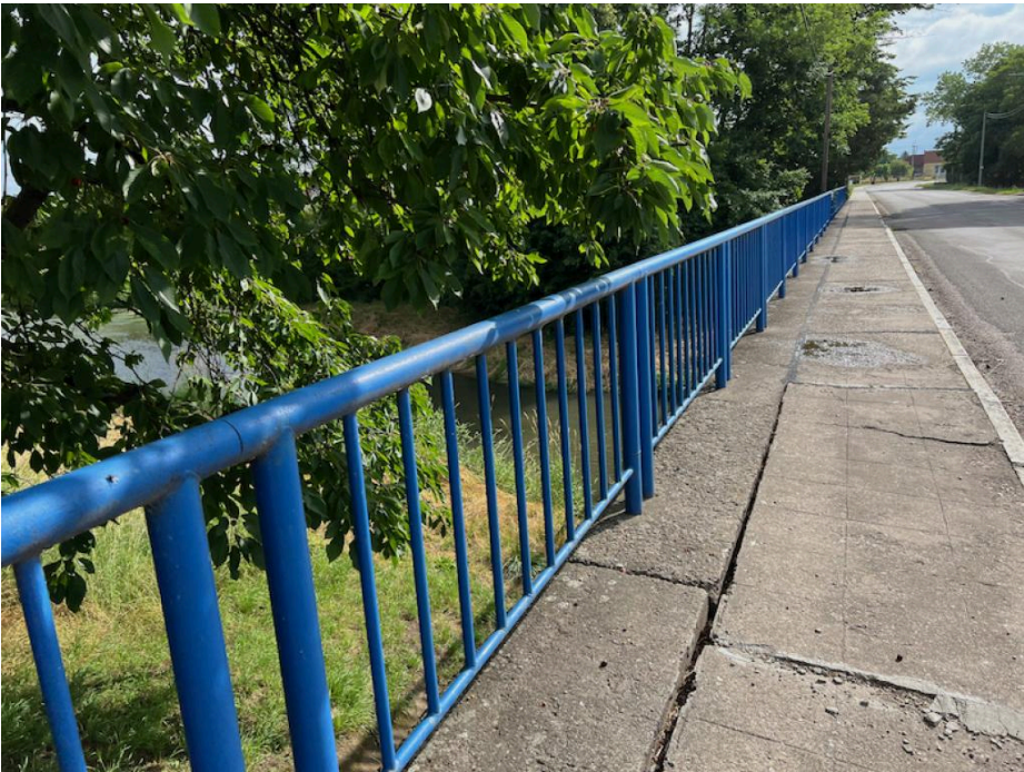
IMG_5440 - otevřená podélná spára v povrchu pravé římsy
