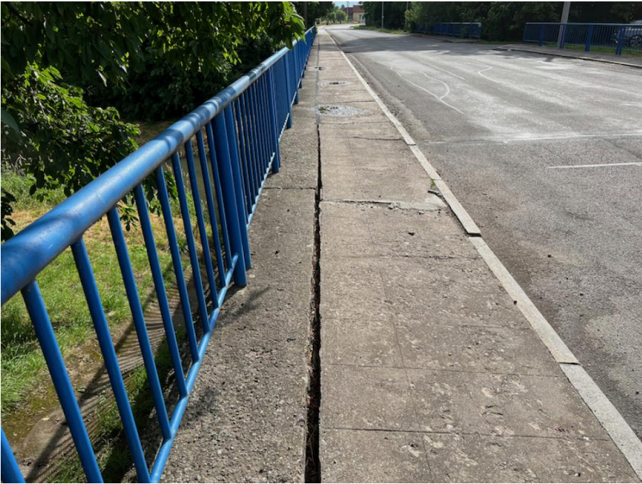
IMG_5436 - otevřená podélná spára v povrchu pravé římsy
