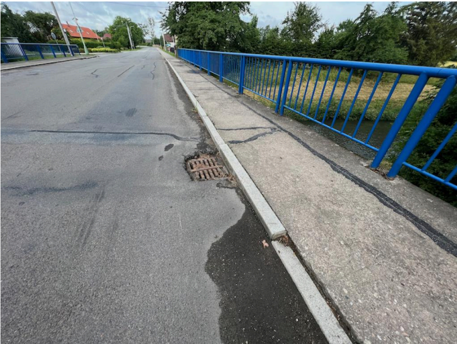
IMG_5393 - propadlá obruba pravé římsy na začátku mostu
