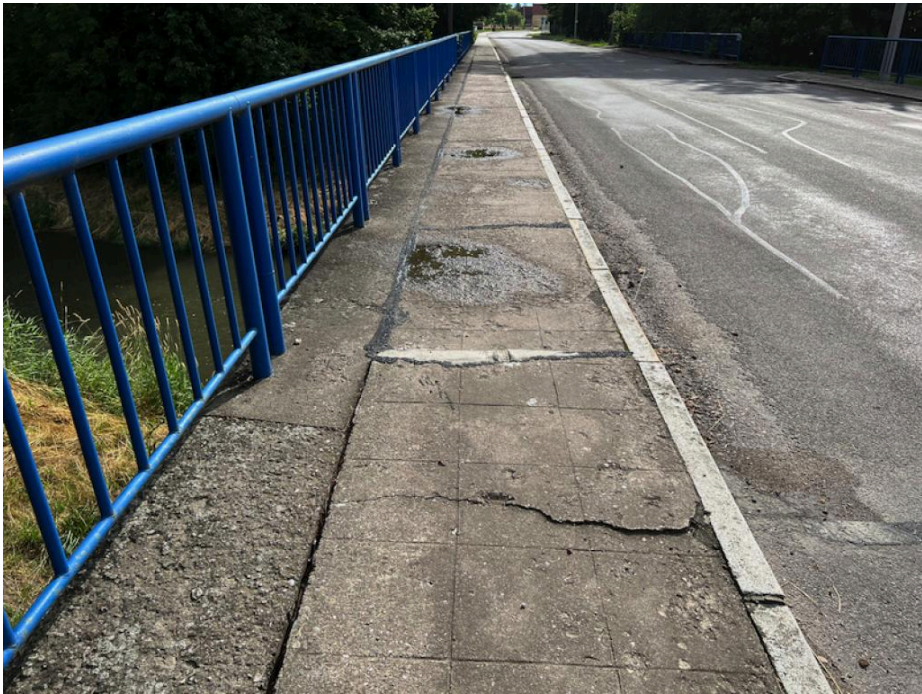
IMG_5442 - na površích říms jsou otevřené trhliny
