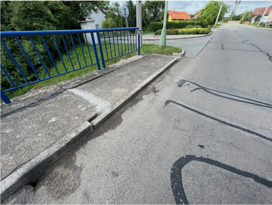
IMG_5409 - propadlá obruba levé římsy na konci mostu
