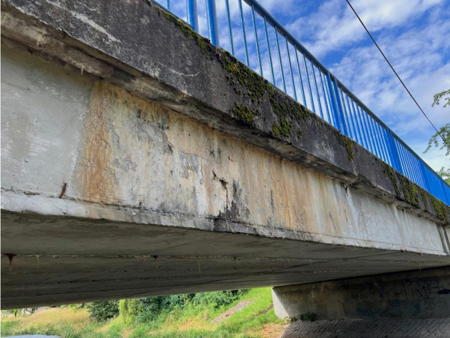
IMG_5501 - patrné stopy po zatékání na boční plochy NK
