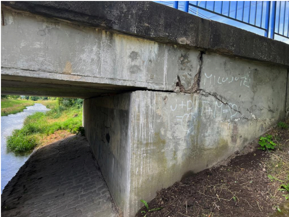
IMG_5525 - koncový příčník na konci mostu vpravo hloubkově degraduje!
