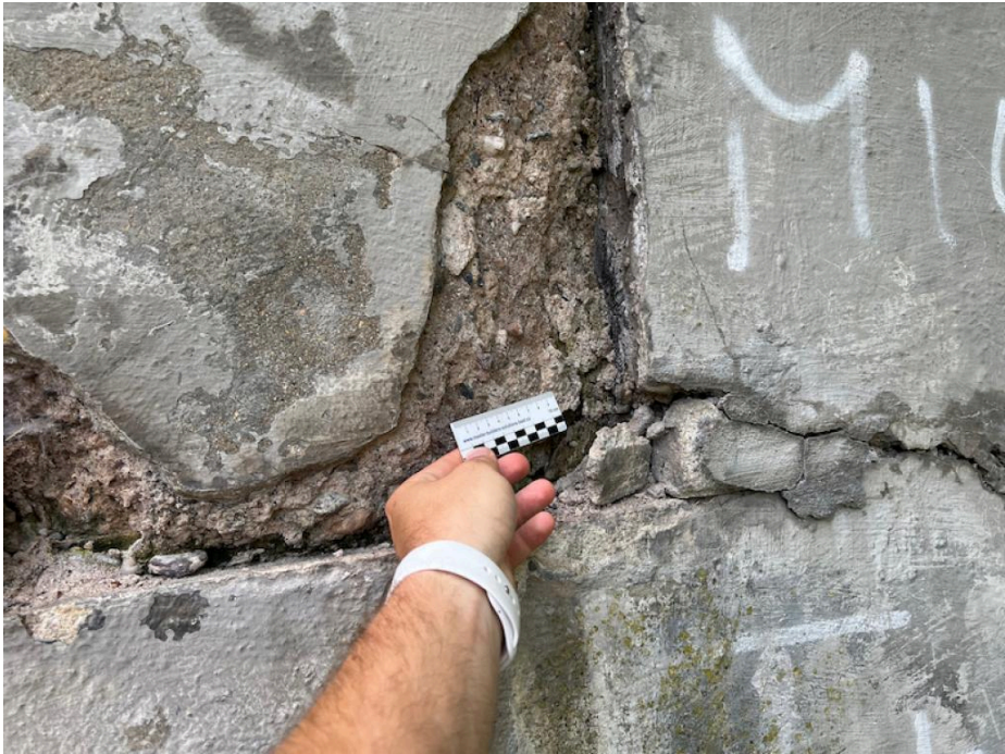
IMG_5531 - koncový příčník na konci mostu vpravo hloubkově degraduje!
