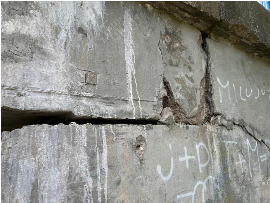
IMG_5528 - koncový příčník na konci mostu vpravo hloubkově degraduje!
