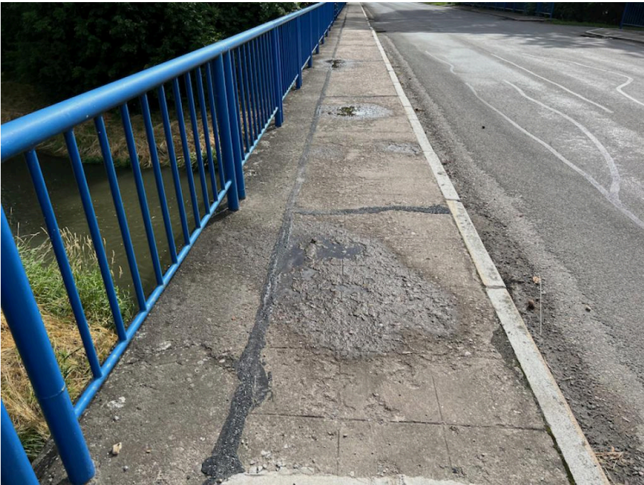
IMG_5443 - na površích říms jsou otevřené trhliny
