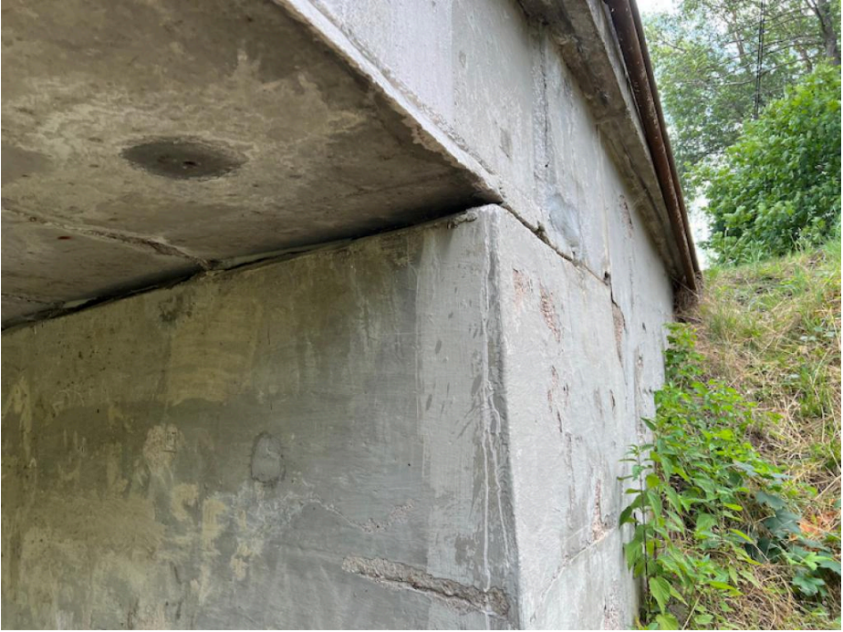
IMG_5470 - na opěrách místy nepravidelné trhliny šíře do 0,3mm
