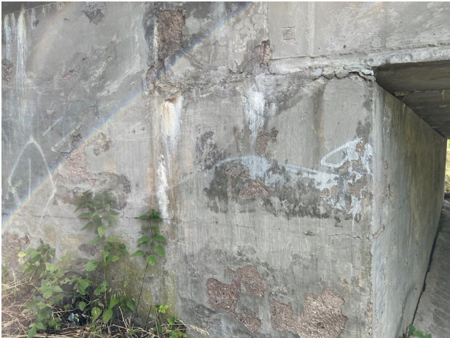
IMG_5480 - na křídlech jsou stopy po zatékání
