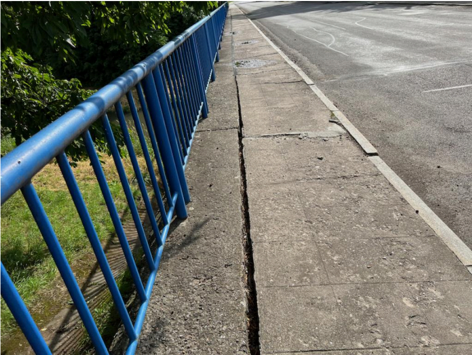
IMG_5438 - otevřená podélná spára v povrchu pravé římsy
