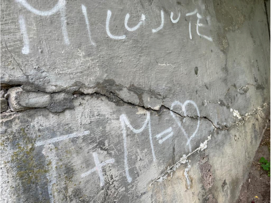
IMG_5532 - masivní diagonální trhlina na křídle K4 , křídlo na konci mírně vykloněné (může pocházet z doby výstavby)
