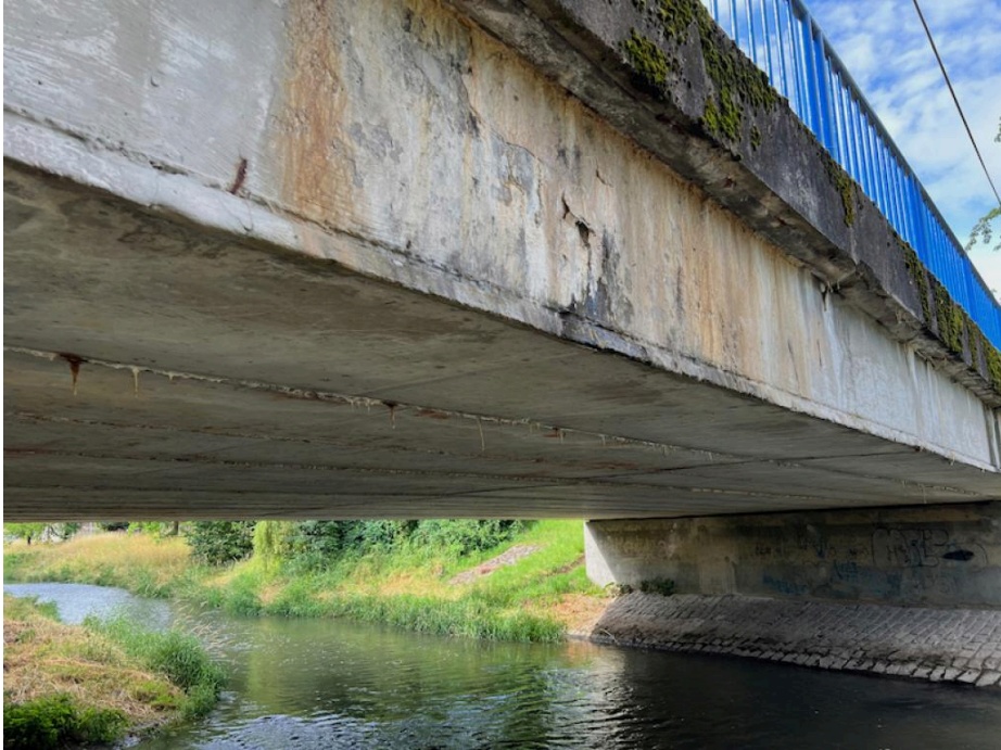
IMG_5500 - patrné stopy po zatékání na boční plochy NK
