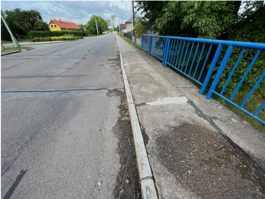
IMG_5403 - lokální nerovnosti vozovky, kaluže
