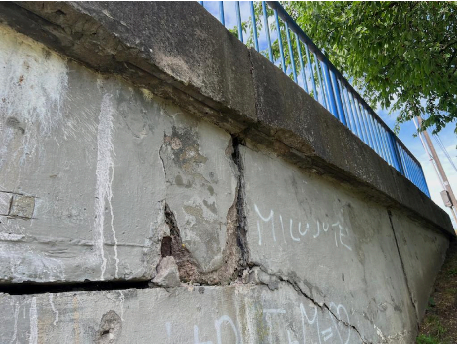
IMG_5529 - koncový příčník na konci mostu vpravo hloubkově degraduje!
