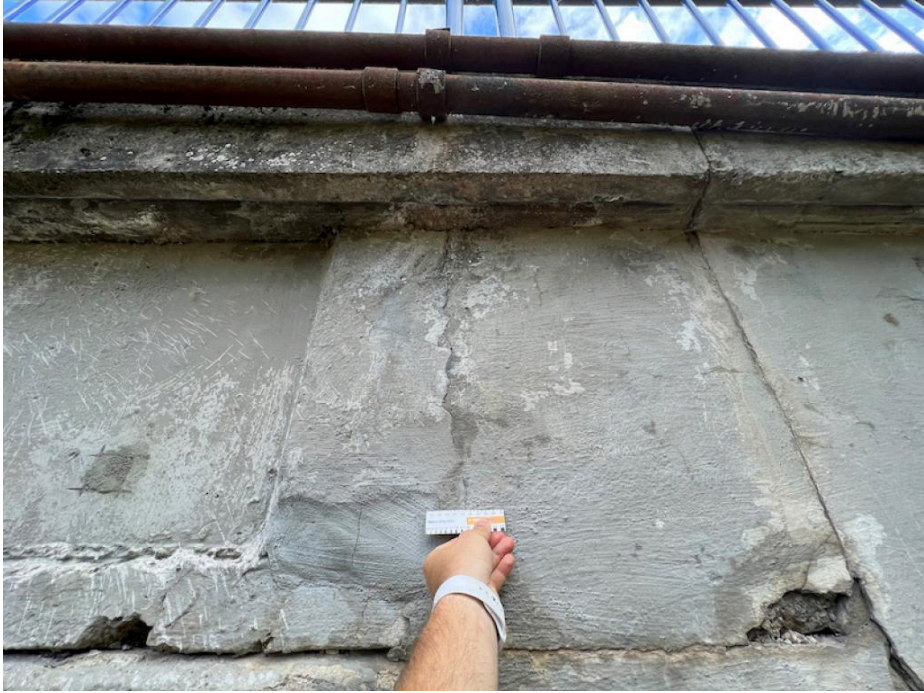
IMG_5466 - svislá trrhlina mezi NK a křídlem K1. šíře do 0,6mm
