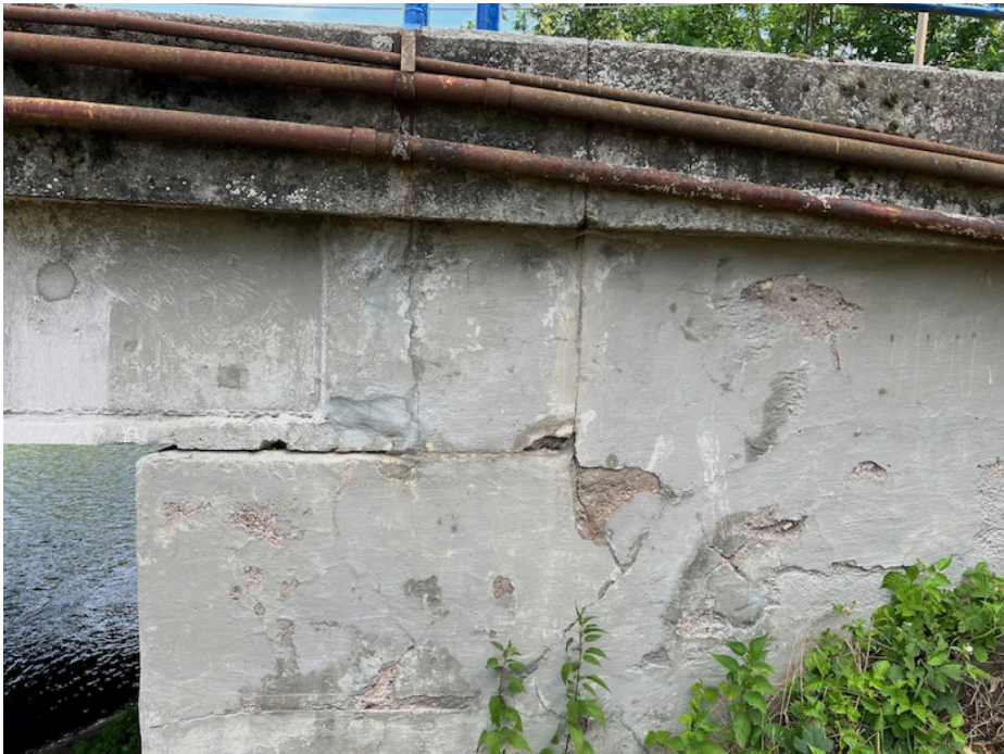
IMG_5459 - povrch křídla K1 povrchově degraduje
