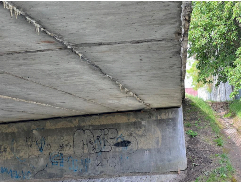
IMG_5499 - patrné stopy po zatékání na podhledu NK (krajní nosníky)
