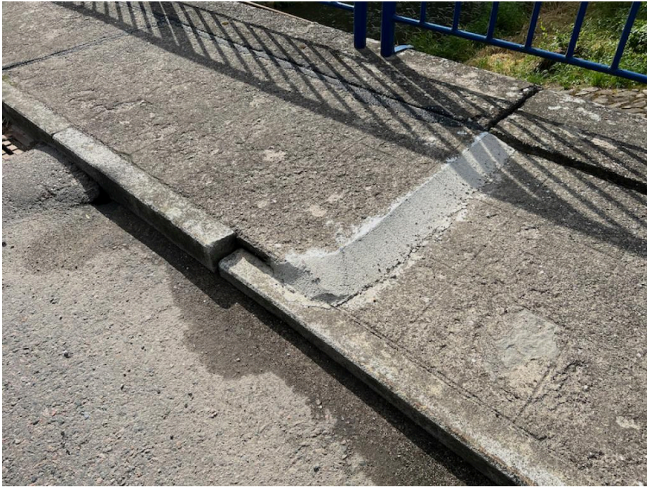
IMG_5428 - propadlá obruba levé římsy na konci mostu
