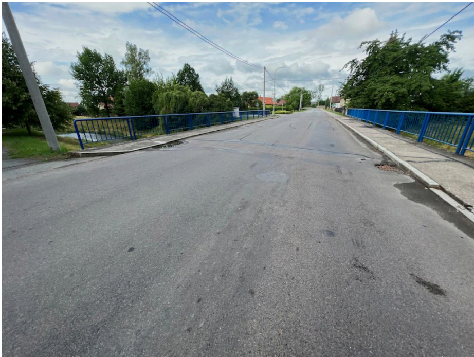
IMG_5390 - výrazný propad vozovky v okolí MZ na začátku mostu !
