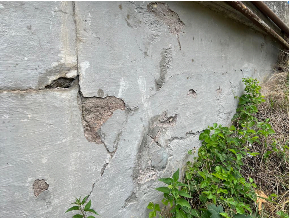
IMG_5463 - povrch křídla K1 povrchově degraduje
