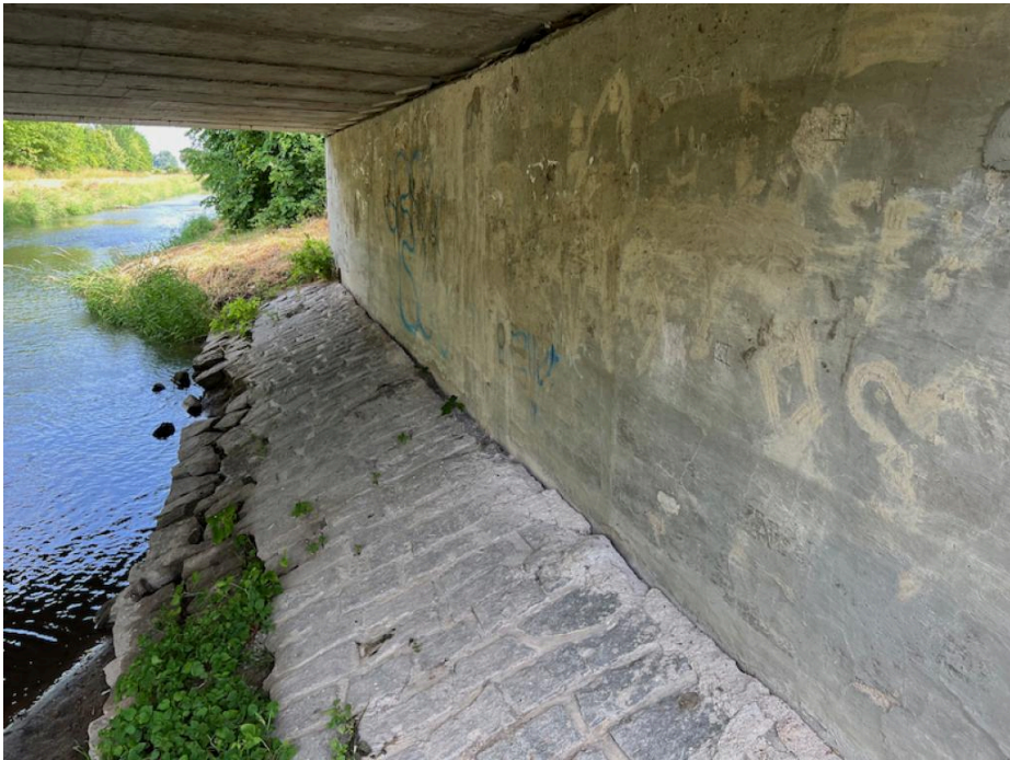
IMG_5472 - poškozená dlažba podél opěry O1
