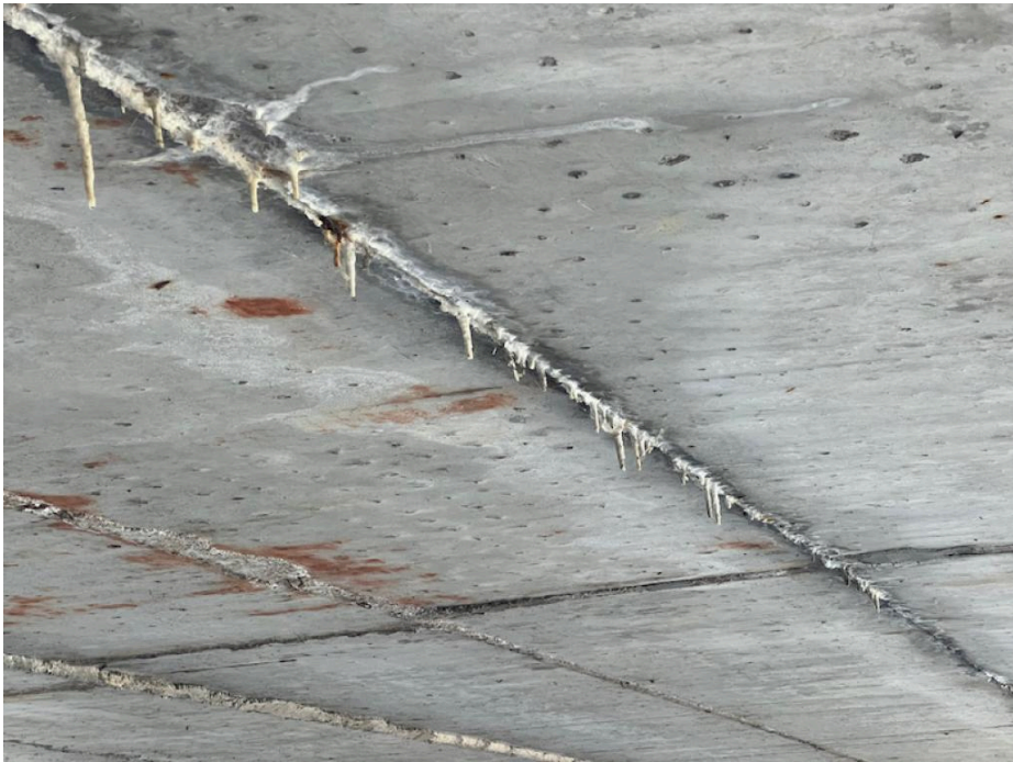
IMG_5498 - patrné stopy po zatékání na podhledu NK (krajní nosníky)
