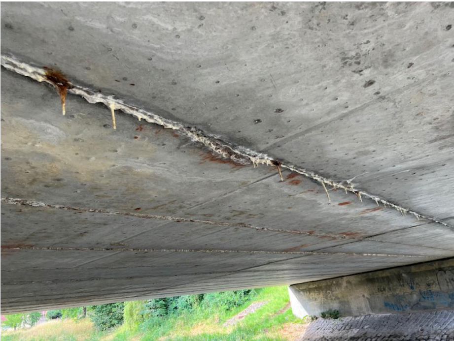
IMG_5496 - patrné stopy po zatékání na podhledu NK (krajní nosníky)
