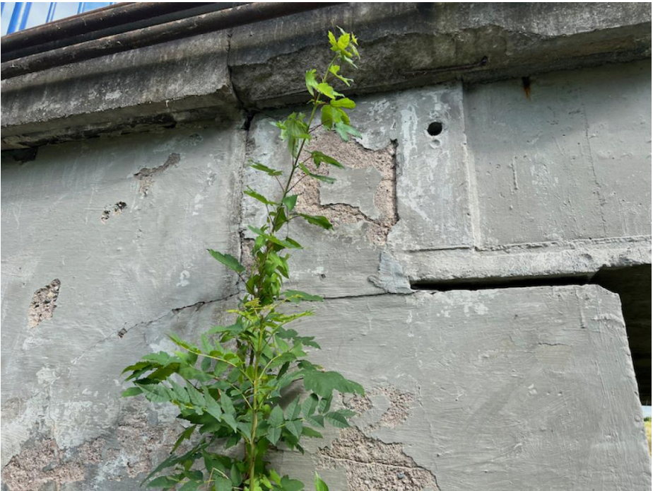
IMG_5512 - povrch křídla K3 povrchově degraduje
