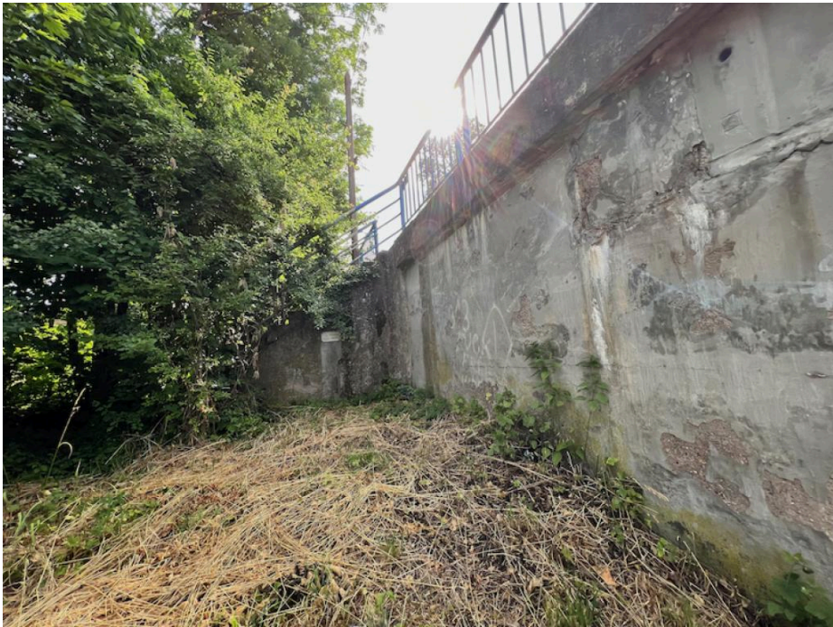
IMG_5478 - povrch křídla K2 povrchově degraduje
