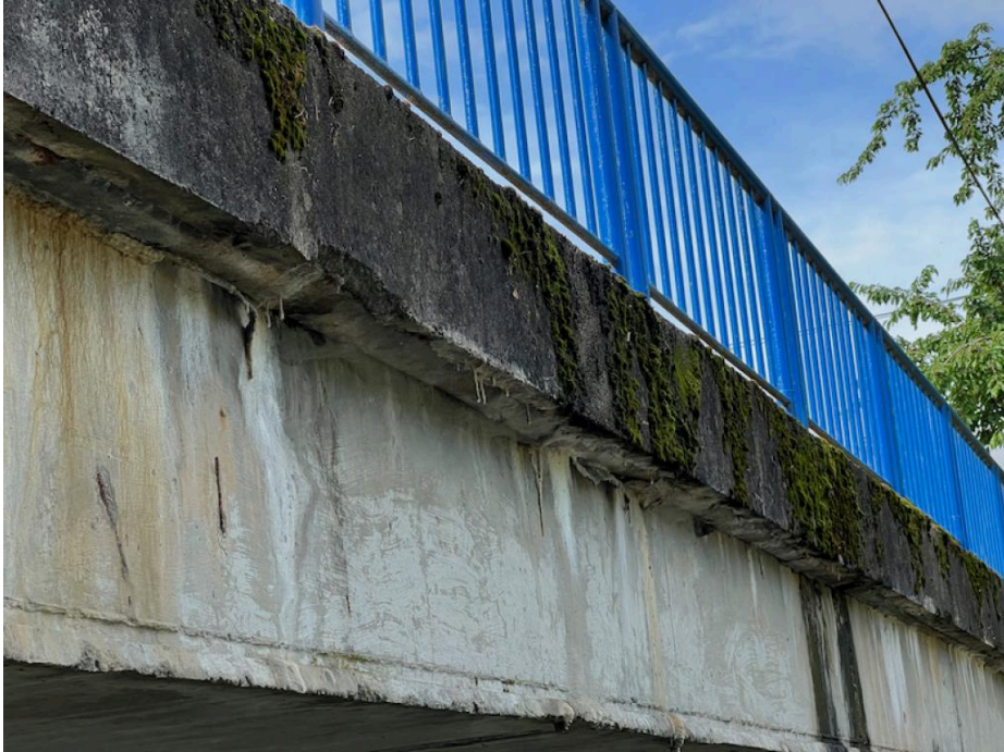
IMG_5503 - patrné stopy po zatékání na boční plochy NK
