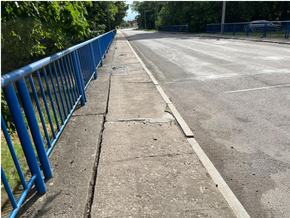
IMG_5439 - otevřená podélná spára v povrchu pravé římsy
