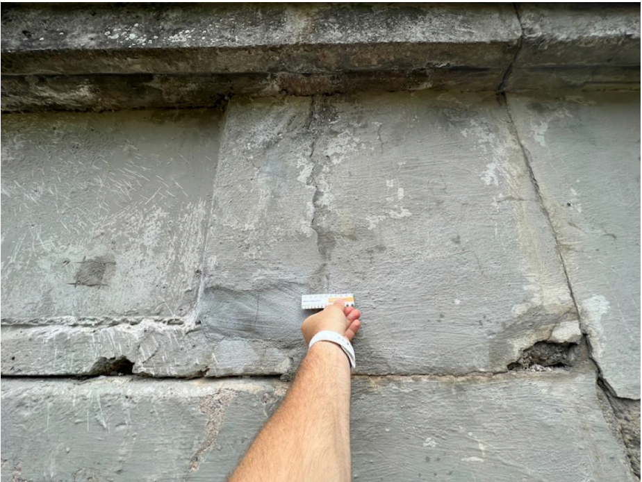
IMG_5465 - svislá trrhlina mezi NK a křídlem K1. šíře do 0,6mm
