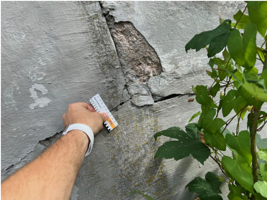
IMG_5514 - trhliny na křídle K3, šíře až 3 mm
