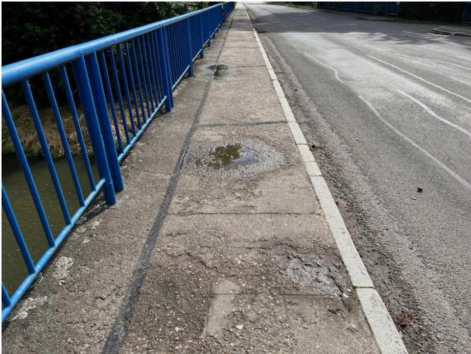
IMG_5446 - na površích říms jsou otevřené trhliny
