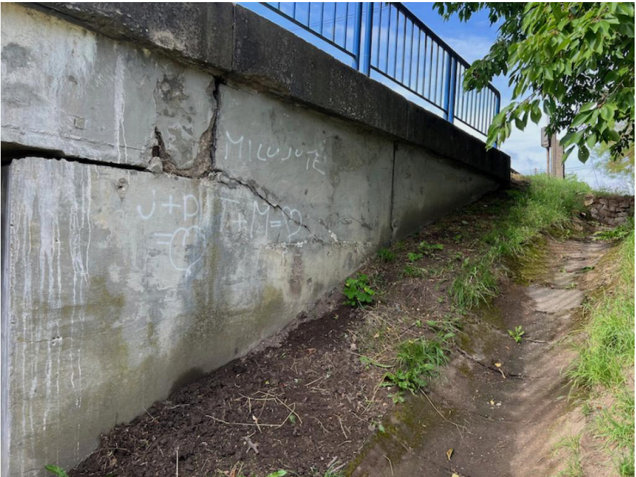
IMG_5527 - koncový příčník na konci mostu vpravo hloubkově degraduje!
