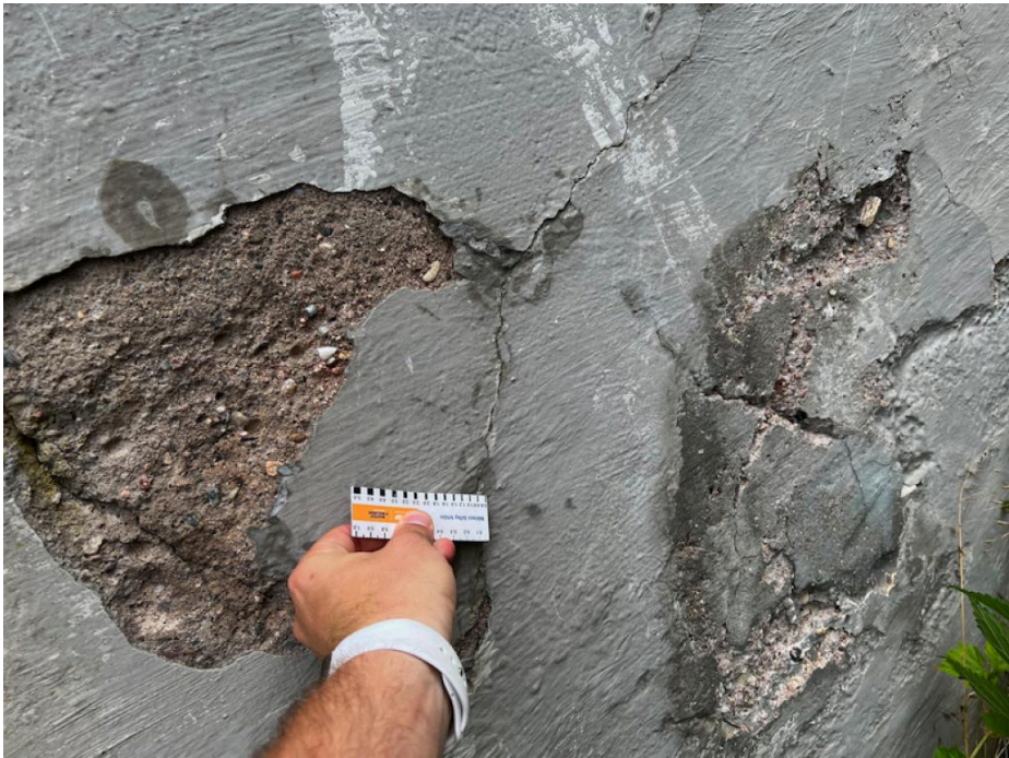
IMG_5464 - povrch křídla K1 povrchově degraduje
