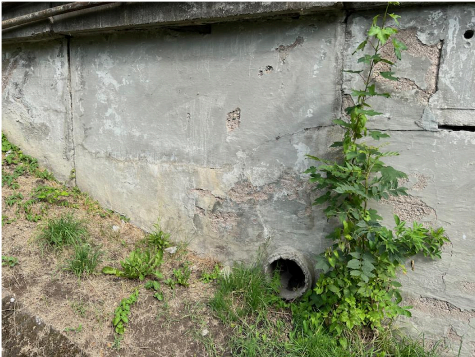
IMG_5508 - povrch křídla K3 povrchově degraduje
