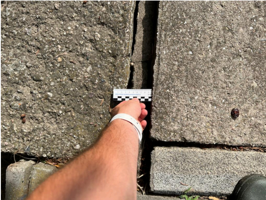
IMG_5437 - otevřená podélná spára v povrchu pravé římsy
