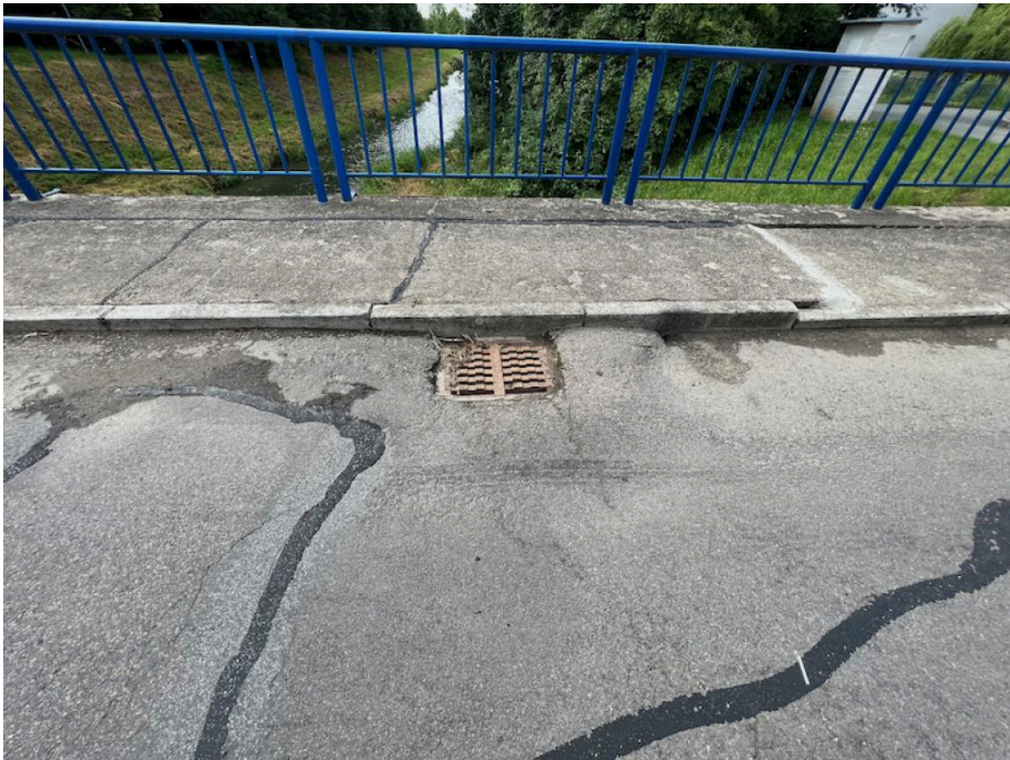
IMG_5407 - vpustě jsou propadlé vůči vozovce až o 50mm (možno způsobeno převrstvením vozovky)
