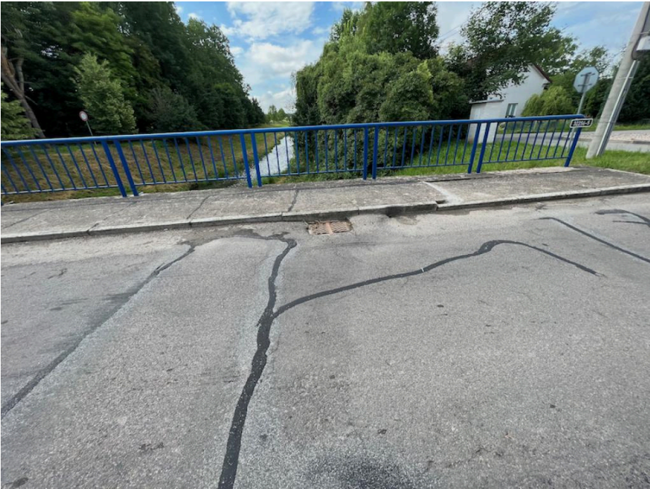
IMG_5405 - výrazný propad vozovky v okolí MZ na konci mostu !
