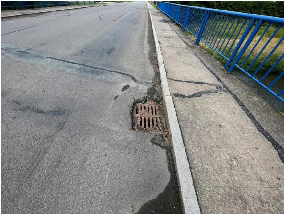
IMG_5394 - vpustě jsou propadlé vůči vozovce až o 50mm (možno způsobeno převrstvením vozovky)
