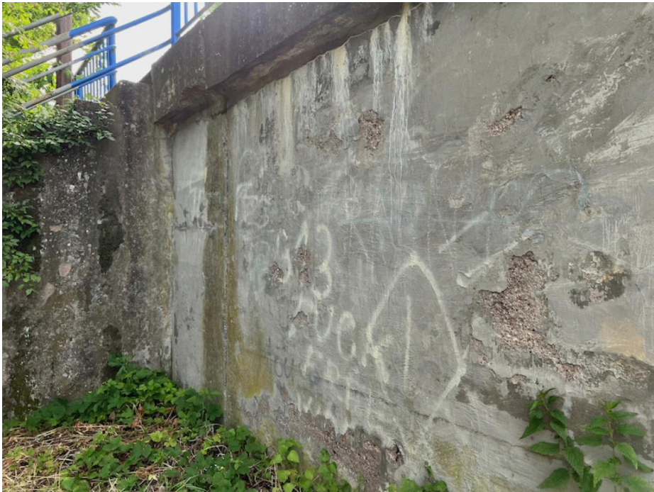
IMG_5482 - na křídlech jsou stopy po zatékání
