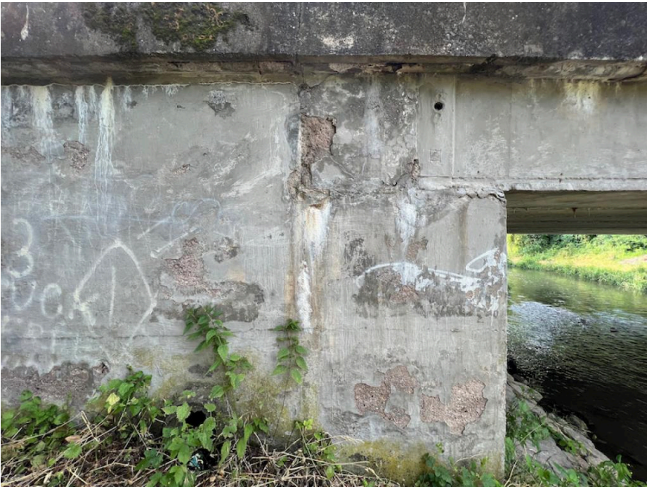
IMG_5485 - degradace betonu příčnicku na začátku mostu vpravo
