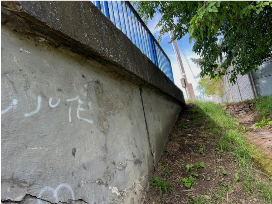
IMG_5533 - na křídle K4 se vyskytují nepravidelné trhliny do 0,3mm, lokálně výluhy
